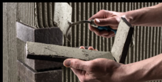
С уголками работают по методу двойного намазывания.
